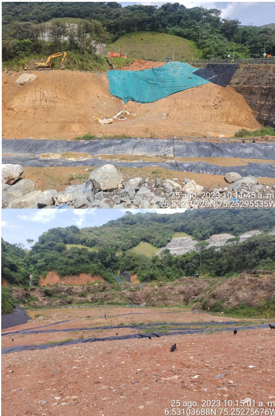
Fotografía 23. Estado del área de cambio menor en Altair.
