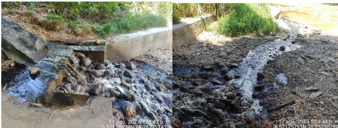
Fotografía 24. Estado del vertimiento de lixiviados (17/08/2023).
