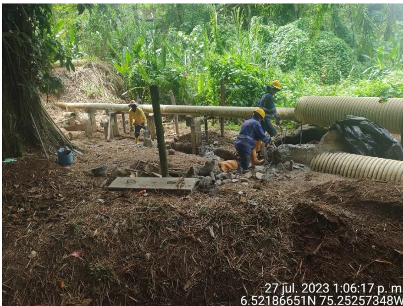
Fotografía 14. Actividades para la instalación de la canaleta Parshall en el punto de descarga del vertimiento del Relleno Sanitario La Pradera.
