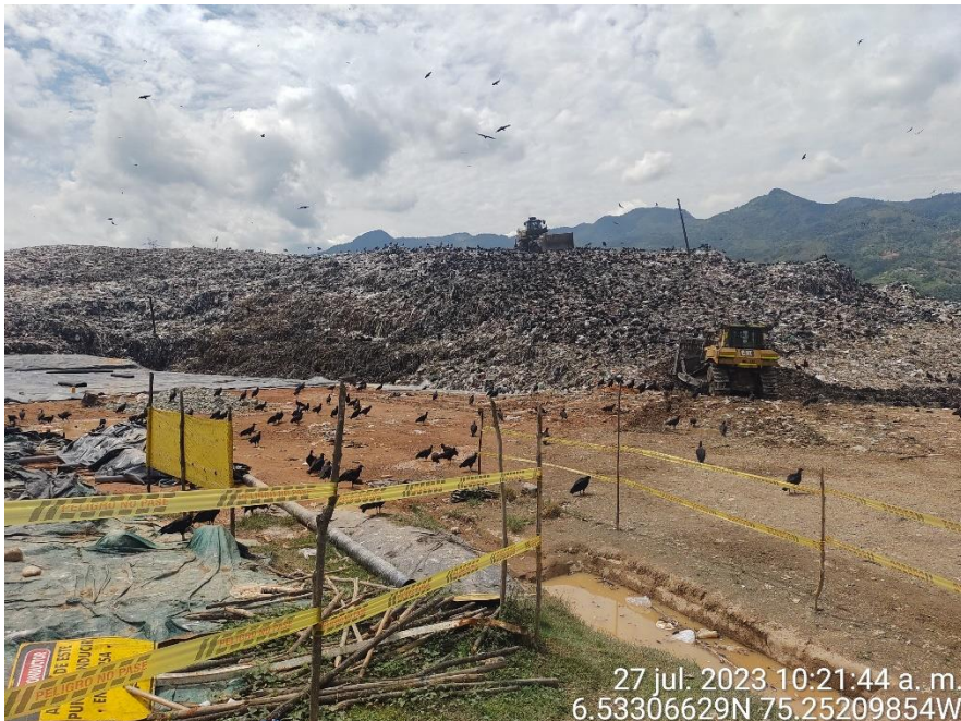
Fotografía 9. Estado de la plataforma de disposición P-26.
