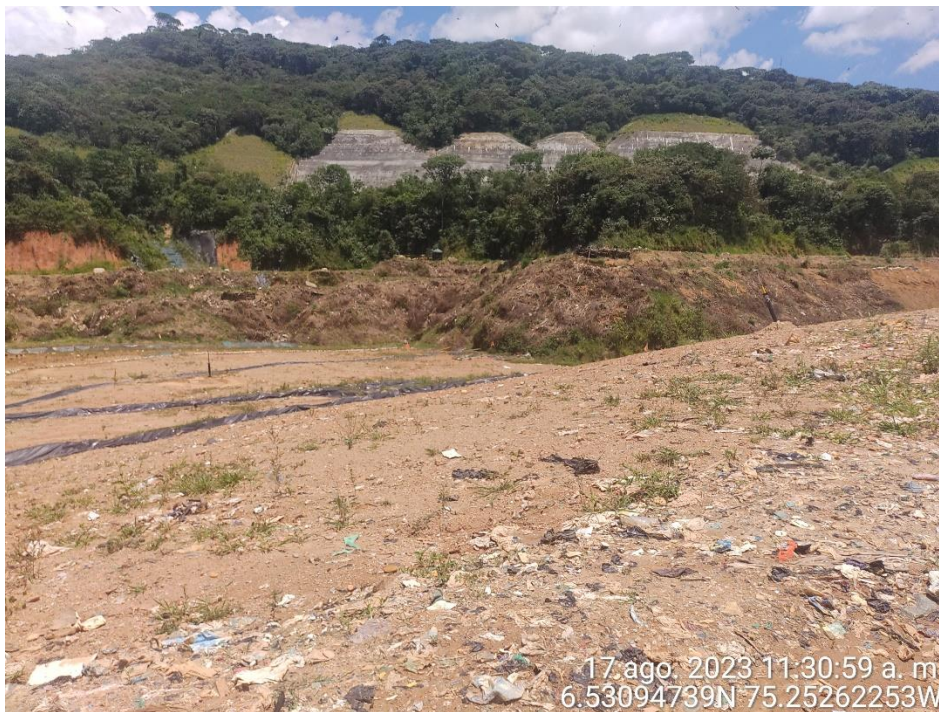
Fotografía 23. Estado del área total de ampliación del vaso Altair.
