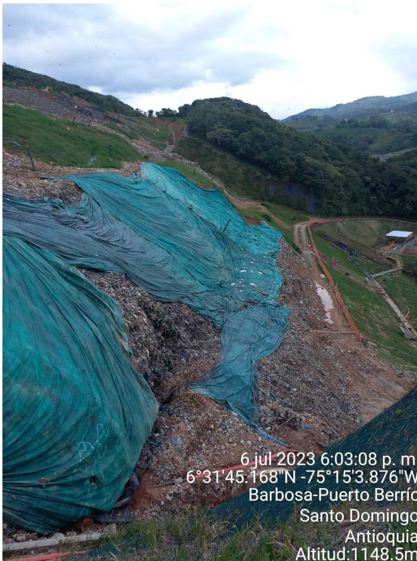
Fotografía 1. Vaso Altair. Estado de la masa de residuos sobre el dique sur (06/07/2023)
