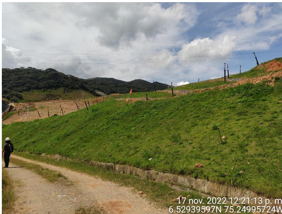
Fotografía 3. Chimeneas activas en la zona del dique sur en noviembre de 2022.
