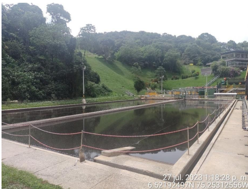
Fotografía 13. Piscinas de pretratamiento del Relleno Sanitario La Pradera.
