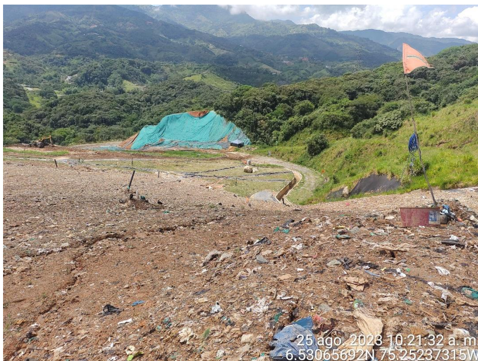
Fotografía 22. Grieta identificada en la masa de residuos de la zona media del vaso Altaír.
