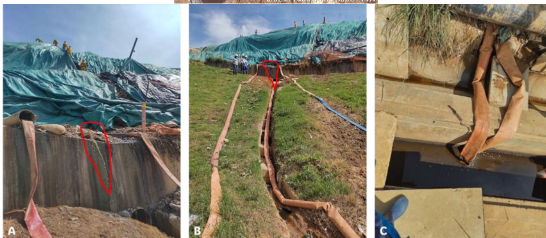
Fotografía 6. Lixiviados sobre la superficie de la sección expuesta del dique sur. Berma 1084 msnm.
