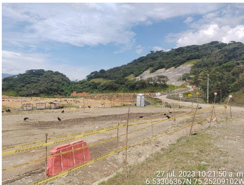
Fotografía 10. Estado del área de cambio menor en Altaír.
