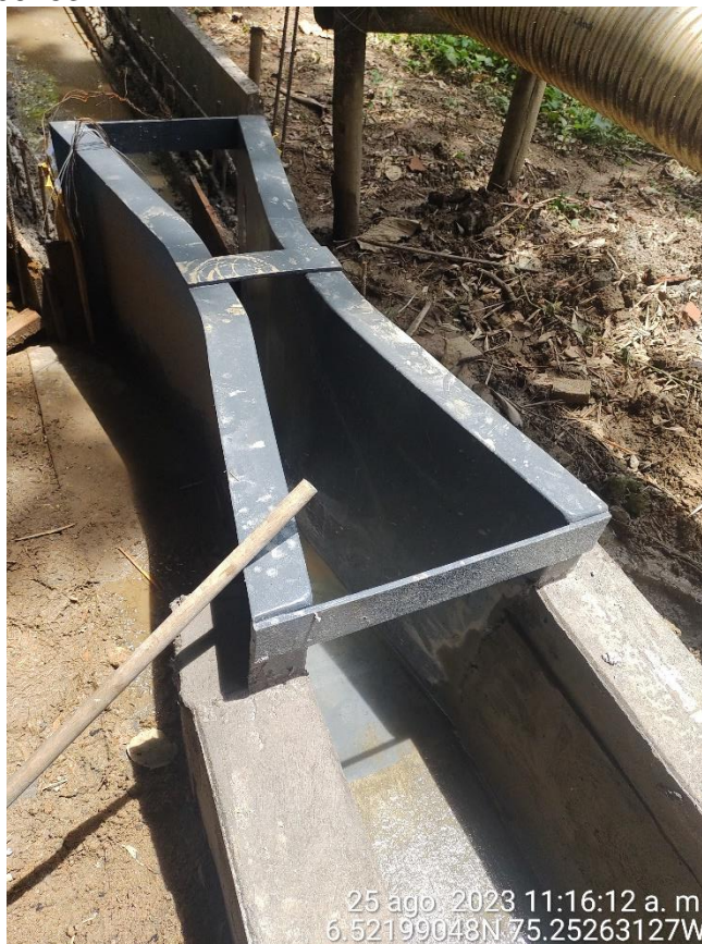
Fotografía 24. Avance en la instalación de la canaleta Parshall en el punto de descarga de lixiviados (25/08/2023).
