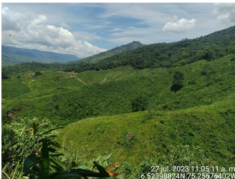
Fotografía 12. Estado de adecuación del vaso La Piñuela.
