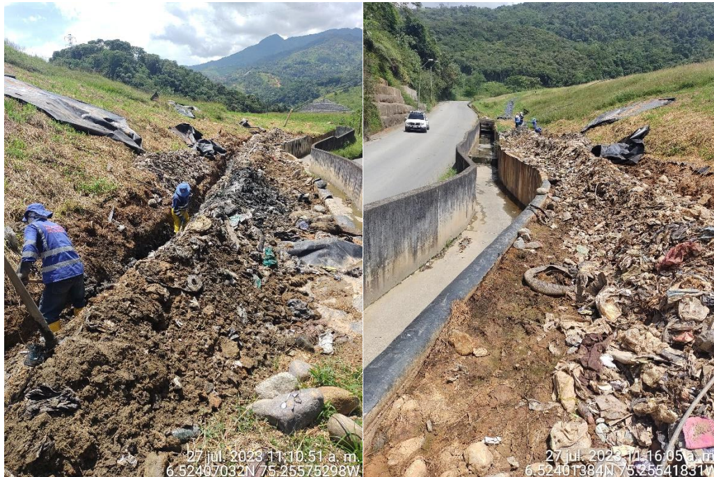
Fotografía 11. Labores de mantenimiento correctivo de filtros en el Vaso la Música.
