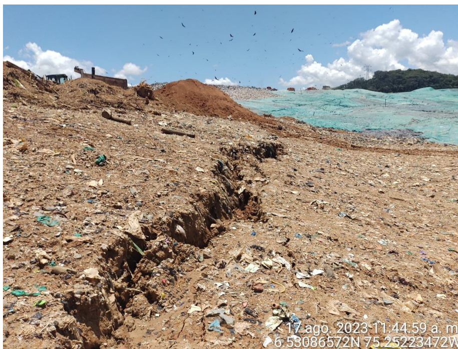
Fotografía 21. Falla identificada en la masa de residuos.
