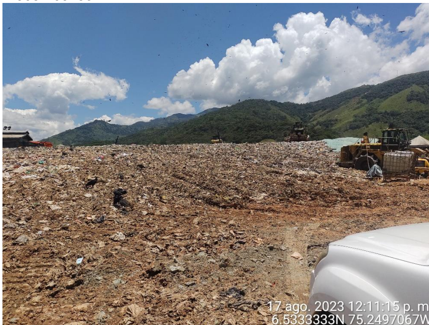
Fotografía 20. Estado de las plataformas de disposición P26 y P27.
