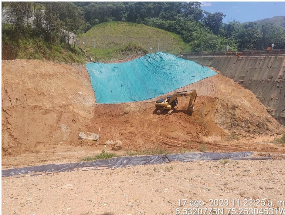
Fotografía 22. Estado del área de ampliación del vaso Altair.
